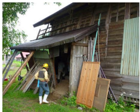
激しく被災し、傾いた土蔵
